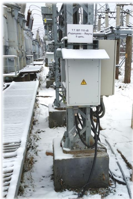
Рис. 8. Выносной блок БВ.ТТ-01 на ОРУ ПС Радищево
