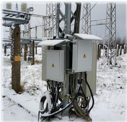
Рис. 7. Выносной блок БВ.ТН-01 на ОРУ ПС Радищево
