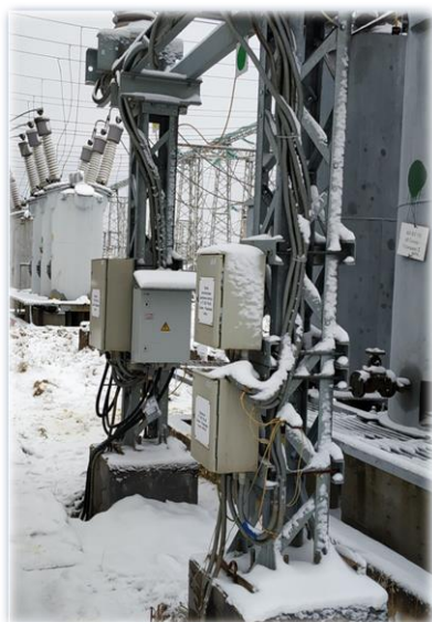
Рис. 9. Выносной блок БВ.УС-01 на ОРУ ПС Радищево
